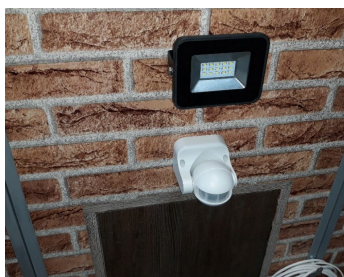
Slika 12. Reflektor sa senzorom pokreta [Izvor: autori]
