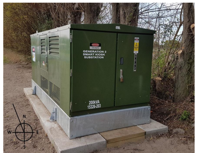
Slika 4. Kompaktna TS u pogonu
