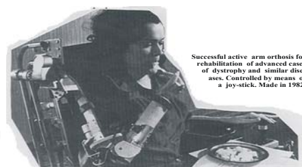
Slika 6. Aktivna ortoza ruke sa elektromehaničkim pogonom - namenjena osobama sa mišićnom distrofijom. Napravljena je 1982. godine
