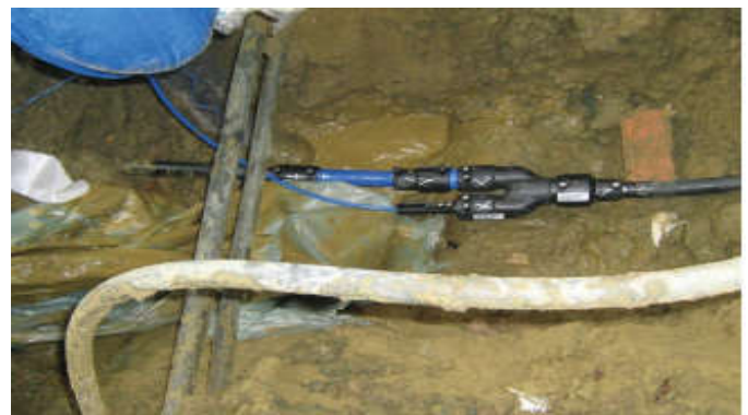
Slika 5. Uvlačenje mikrocijevi u vodovodne cijevi[2]
