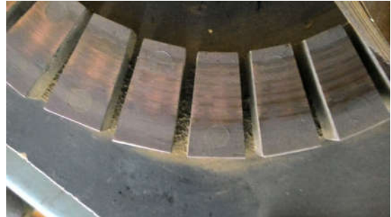
Slika 5. Bakarni kontakti sa efektom prebrisavanja
