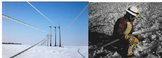
Slika 5. Pad provodnika usljed leda
