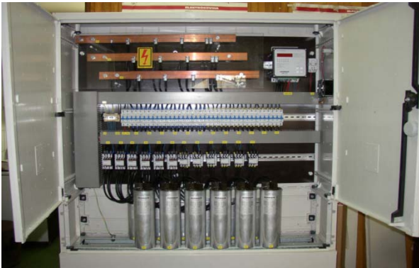
Slika 4. Šema ormara sa elementima za kompenzaciju
