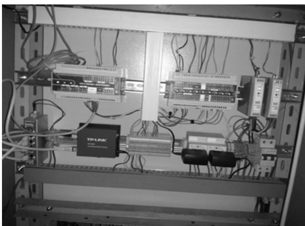
Slika 7. Na slici je dat prikaz procesorske jedinice: ethernet kontroler, U/I galvanski izolovan modul, mrežni ruter, optički konvertor i dva modularna napajanja.
