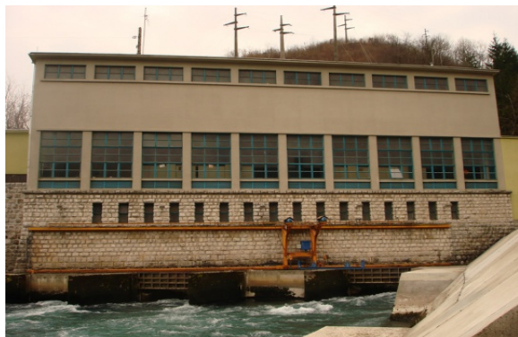
Slika 1. Mala hidroelektrana Una Kostela [7]
