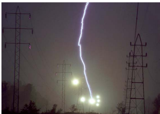
Slika 1. Atmosfersko pražnjenje u visokonaponske vodove praćeno pojavom kvara
