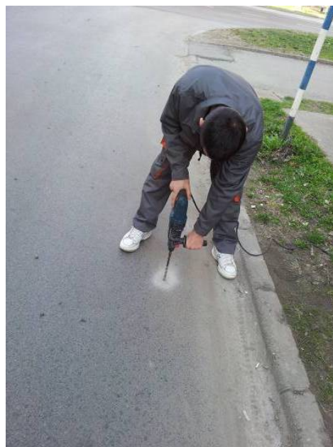
Slika 2. Priprema otvora za postavljanje senzora.
