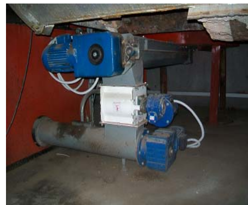
Slika 3. Pužni dozatori sa elektromotornim pogonom
