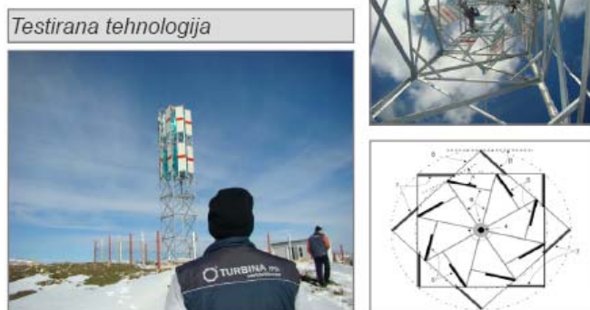
Slika 7. Izgled i postavljanje malih vjetroelektrana
