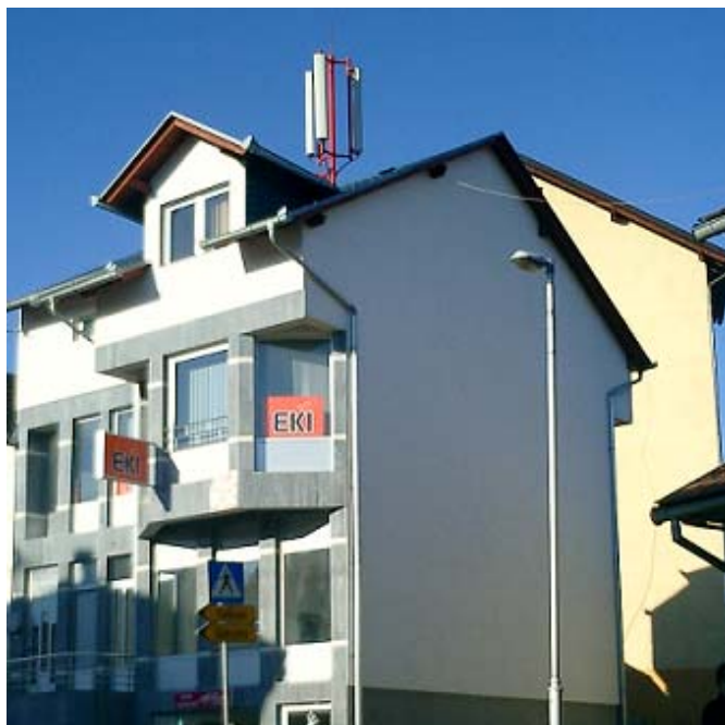
Slika 4. GSM900 antene instalirane na krovu u visini tijela
